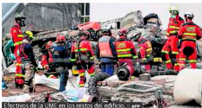
Efectivos de la UME en los restos del edificio. :: AFP
